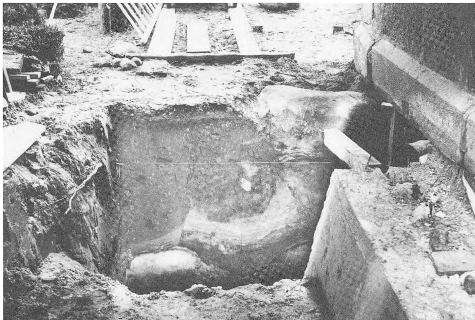
Profil 1: Forneden th. ses den nye betonsokkel.
