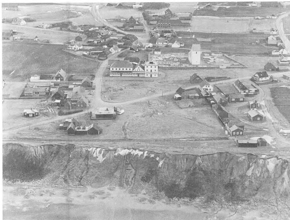
Bovbjerg-området med minder om den tidlige turisme og om Kystinspektoratets arbejde for at sikre kysten. Midt i billedet det nu helt forfaldne Bovbjerg Badehotel, til højre Kystinspektoratets støbeplads, og bag hotellet Ferring kirkegård med de hvide stakitter (fot. Amtsfredningsinspektoratet).
