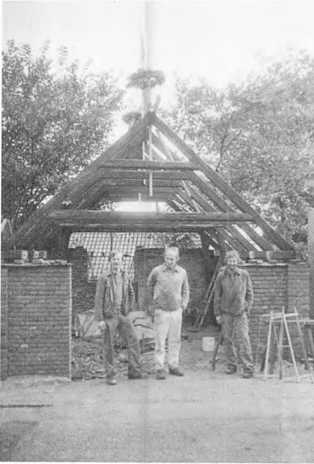
De tre unge håndværkere, som havde hovedopgaverne ved sprøjtehusets istandsættelse. Fra venstre står tømrer Freddy Kristensen, murer Karl Gravensen og tømrer Ove Kristensen.
