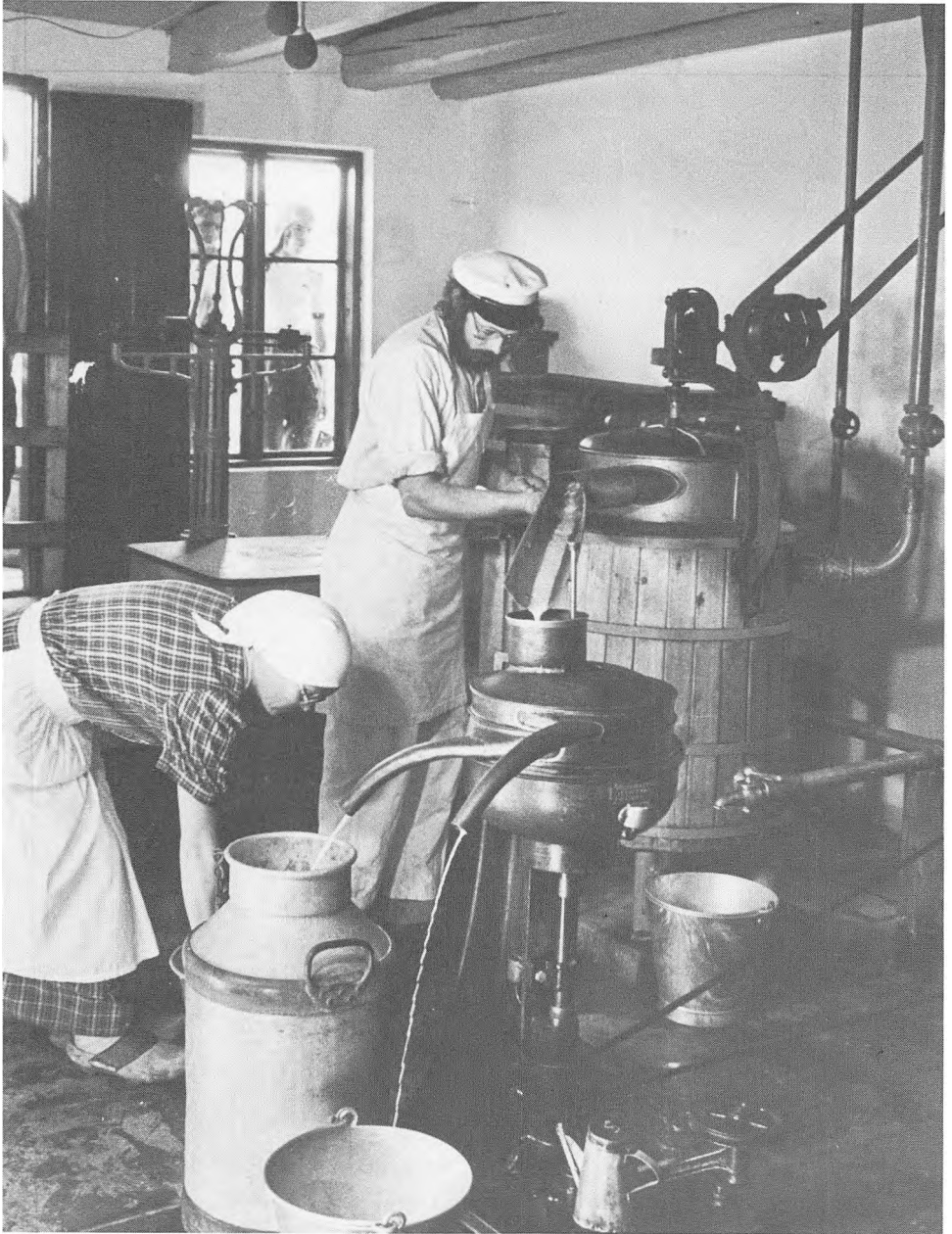
Det lille mejeri fra Mandø, som idag står fuldt monteret med mejerimaskiner til fremstilling af smør, og hvor drivkraften er en lille Marshall dampmaskine fra 1880.
