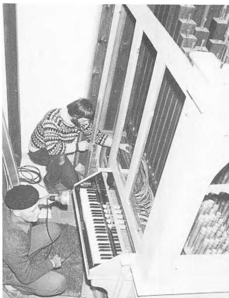
Orgelbyggersvendene Jens P. Jakobsen og Mogens Hansen i gang med at afprøve forbindelserne fra spillebord til vindlade. (Fot. Dagbladet Vestkysten).
