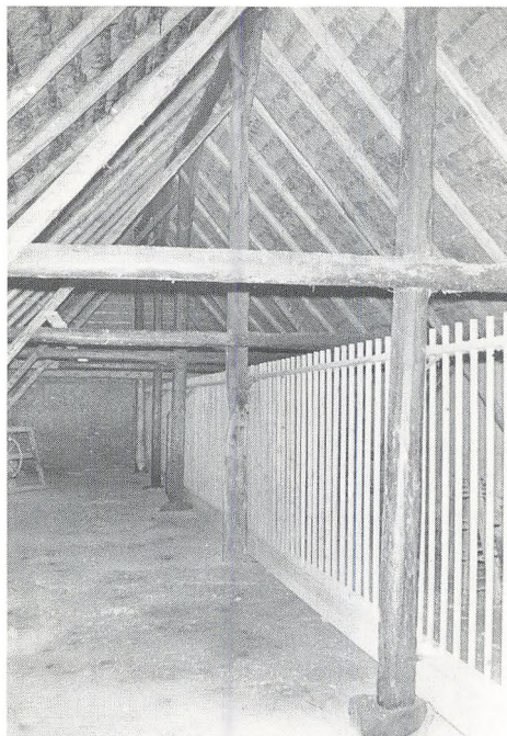
Sulekonstruktionen i laden til et vestjysk gårdanlæg på Hjerl Hedes Frilandsmuseum. Foto: Hjerl Hedes Frilandsmuseum.
