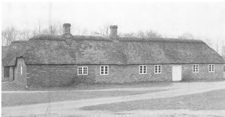
Den såkaldte »sulegård« på Hjerl Hedes Frilandsmuseum. Stuehuset er et eksempel på et ældre, grundmuret hus, hvor vinduer og døre er placeret efter behov og uden hensyntagen til en mere streng, arkitektonisk opbygning af facaden. Foto: Hjerl Hedes Frilandsmuseum.
