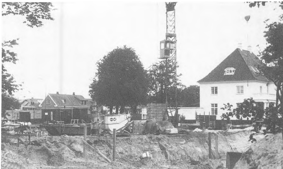
Byggeriet af det nye kulturhistoriske museum kom godt igang i efteråret 1987, med udgravning og støbning af underetagen.
