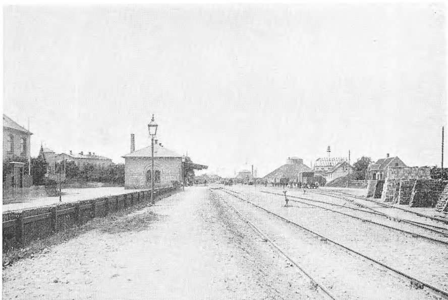
Frederiksberg station straks efter opførelsen. Stationsbygningen ligger der endnu. (Jernbanemuseet).
