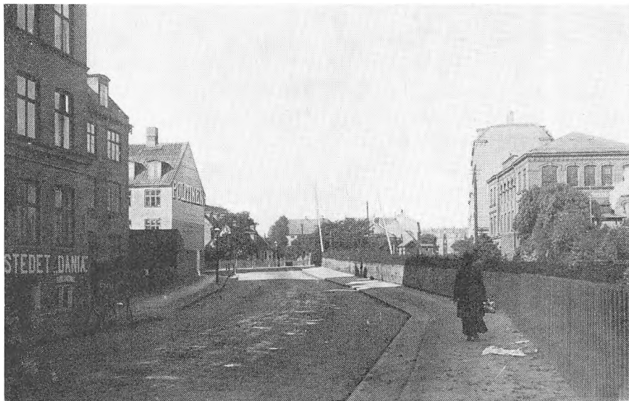
Jernbaneoverskæringen på Fuglevangsvej. Passeredes af togene mod Roskilde og Frederiks-sund. Foto 1913. (Frederiksberg Kommunes Biblioteker).
