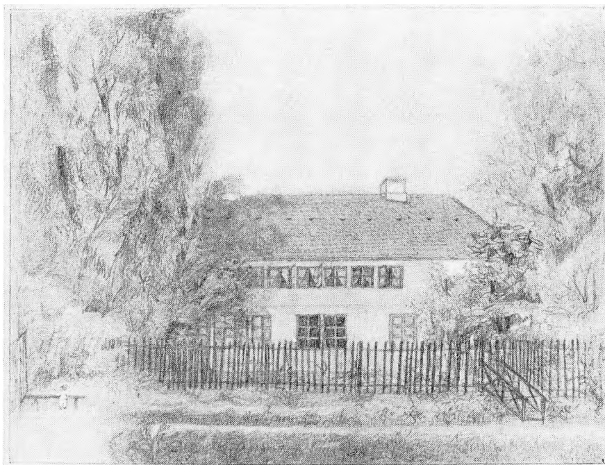
Bakkehusets sydfløj. Fotografi efter tegning ca. 1865 af Susanne Jacobsen. Bakkehusmuseet.
