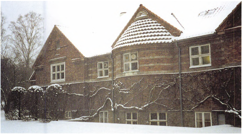
Fig. 4. Bagsiden af den reumatologiske bygning har en helt anden karakter med udprægede mindelser om romersk arkitektur karakteriseret ved de vandrette striber af lyse kalksten og røde mursten og den halvrunde apsis-udbygning midt på sydvestgavlen. Foto Sven Erik Hansen.
