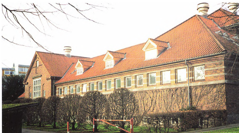
Fig. 3. Langsiden af Badebygningen med det romerske præg i form af de lange vandrette kalkstensbånd i de røde mursten. Bag tagrejsningen er den store tagterrasse, solgården skærmet mod vind og indblik. Foto Sven Erik Hansen
