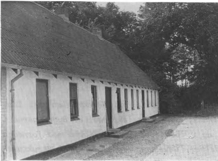
Villerslevgaards stuehus fotograferet fra gårdspladsen 1985.
