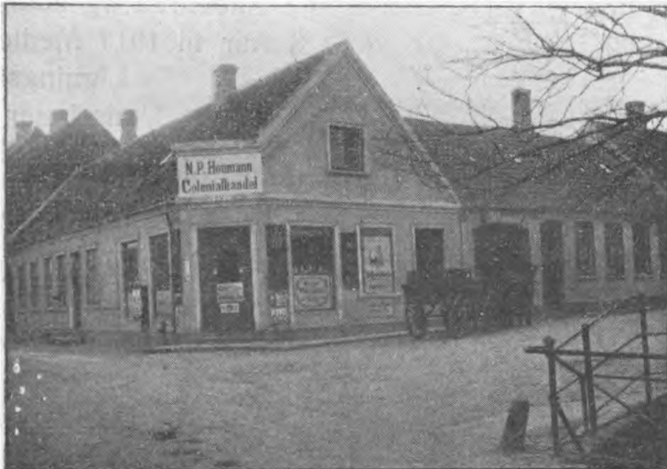
N. P. Houmanns Forretning.
