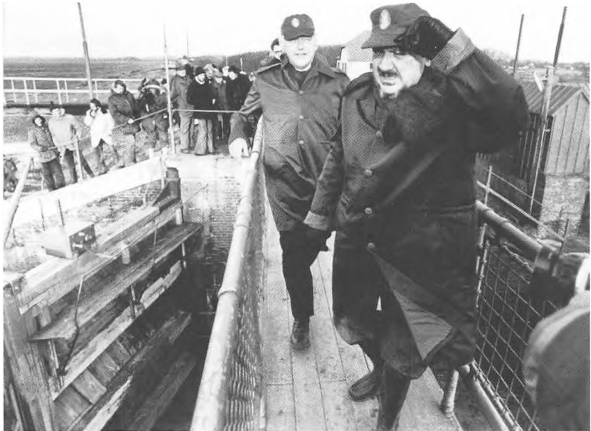
Da statsminister Anker Jørgensen og jeg drog ud på digebesigtigelse umiddelbart efter stormfloden i 1976 iklede politimester Erik Boving med vanlig omhu for sine gæster os i civilforsvarets lune kapper og huer. Her besigtiger vi den gamle Hojer Sluse.
