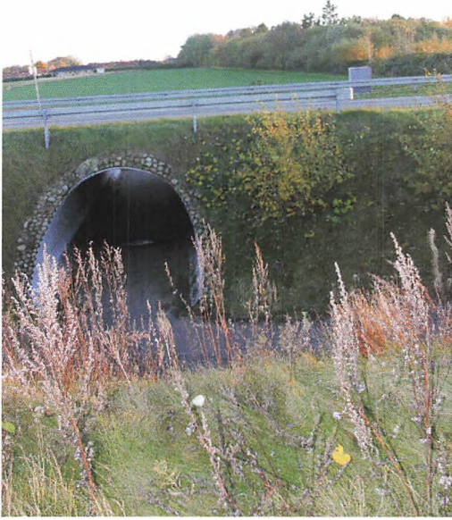
Tunnel under omfartsvej
