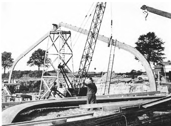
Figur 11: Buerne af lameltræ rejses i september 1966. Det er Poul Ptak på stilladset, mens Svend Lindgren dirigerer arbejdet. (Foto: Fuglebjerg Lokalarkiv).
