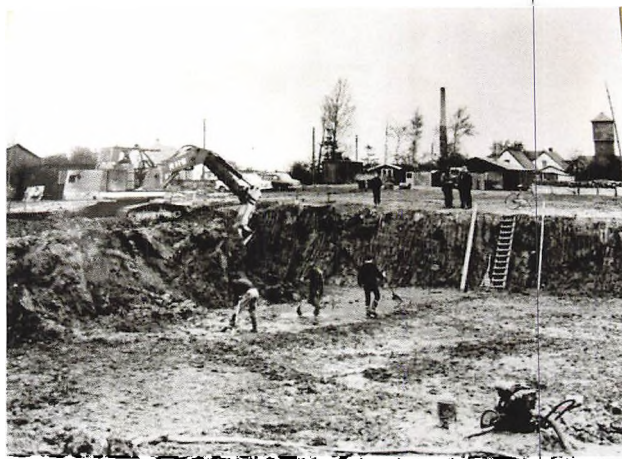
Figur 9: Udgravningen til hallen som den så ud 15. maj 1966. Nederst til højre en pumpe til at holde udgravningen fri for vand. (Foto: Fuglebjerg Lokalarkiv).
