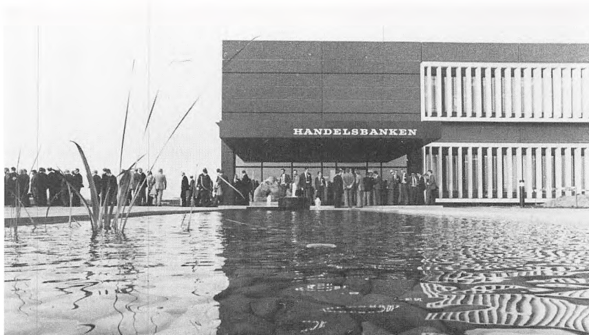
Den 20. januar 1978 var der rejsegilde i Ejby, og inden årets udgang var bygningen arbejdsplads for ca. 900 af bankens medarbejdere.
