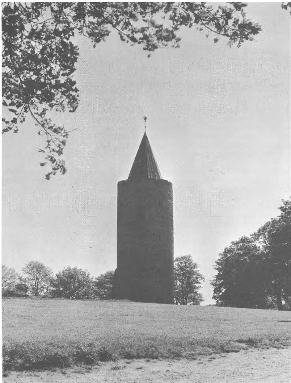
Gåsetårnet i Vordingborg er Danmarks bedst bevarede middelaldertårn. Det er 26 m højt til murkranen og har en omkreds på 33 m. Den nuværende indgang er udhugget i det forrige århundrede. Eneste oprindelig dør, i 8 meters højde, har ført ud til en vægtergang på ringmuren, der delvis er bevaret i terrænet. Interessante detaljer i tårnet er et middelalderligt tømmerværk, der danner tværvæg.
