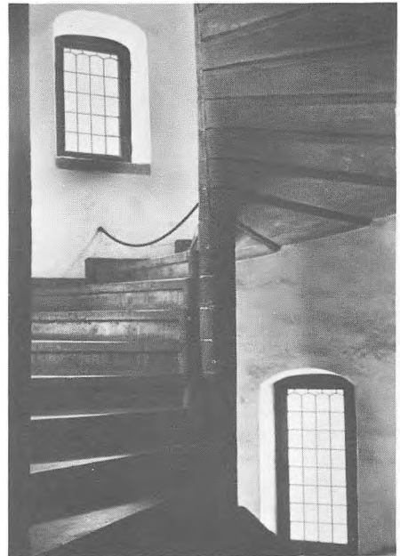
At vindeltrapper normalt er højresnoede er et levn fra borgtiden. Herved kunne en forsvarer fægte med højre hånd samtidig med, at modstanderen nedefra generedes af midterstolpen - medmindre han var kejthåndet.
