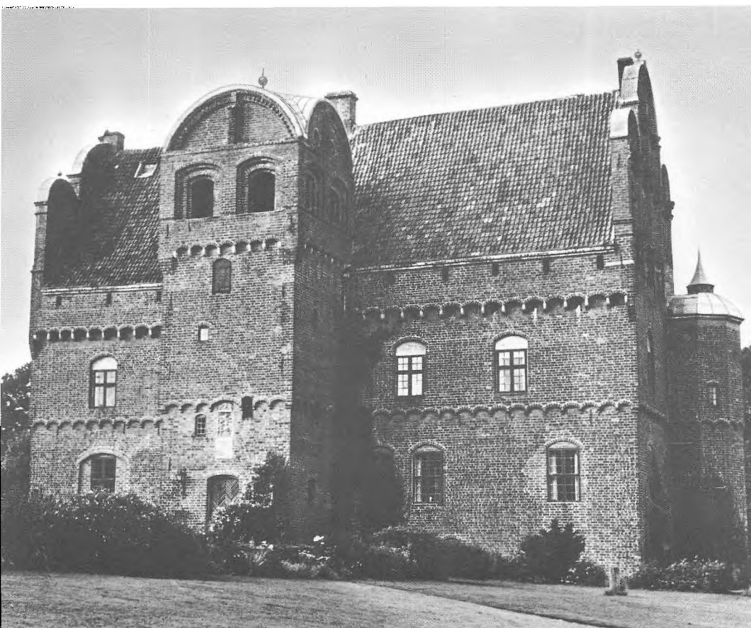
Hesselagergård har et lidt dystert borgpræg. Oppe under taget ses skytte loftets mange glugger og skoldehuller. Gennem hullerne kunne man hælde kogende vand og beg ned over angribere.
