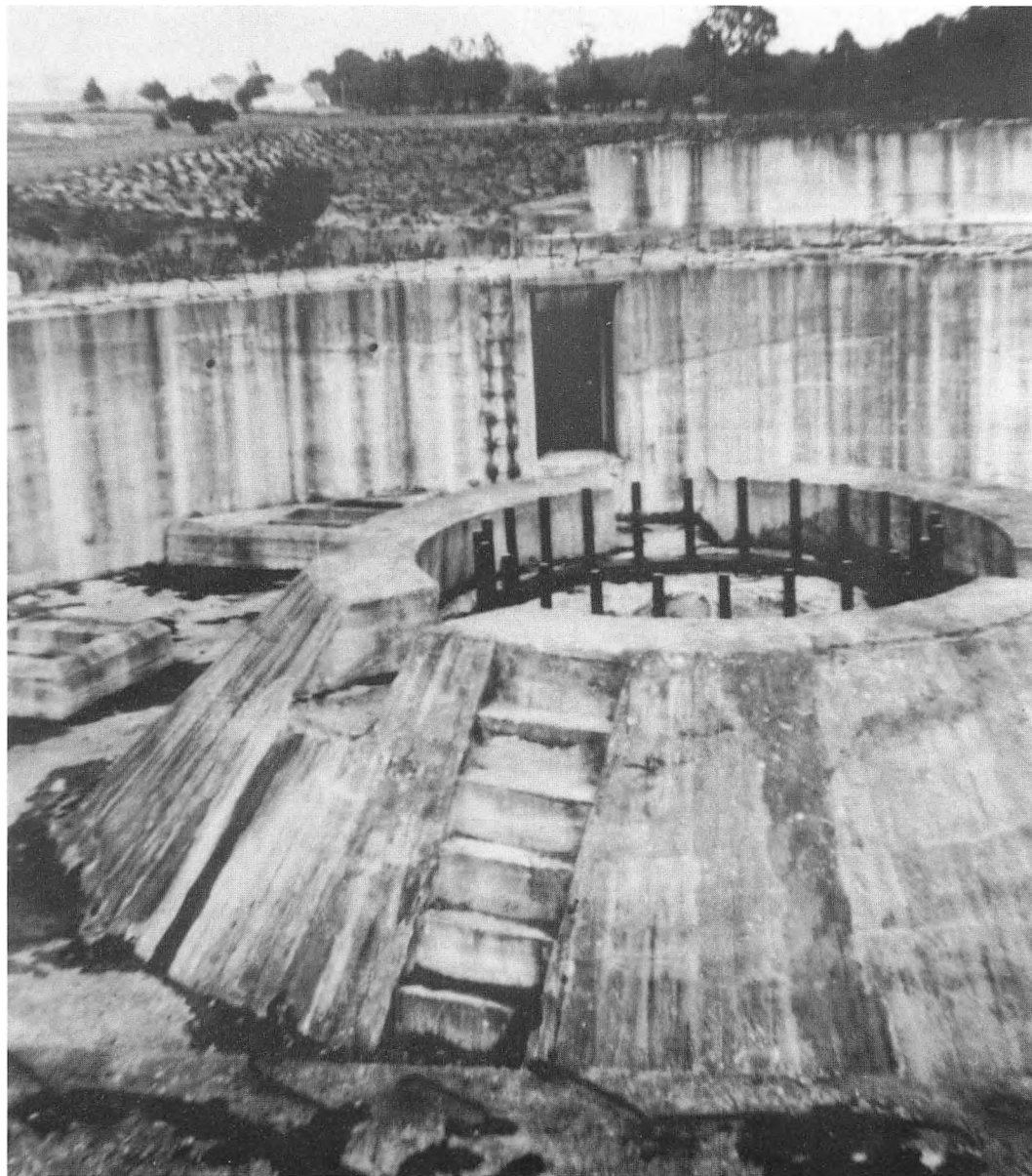
Fig. 1: Én af de to bunkere 1945. På billedet ses soklen med de svære bolte, som kanontårnet skulle have været fastspændt til. (Bornholms Forsvarsmuseum.)
