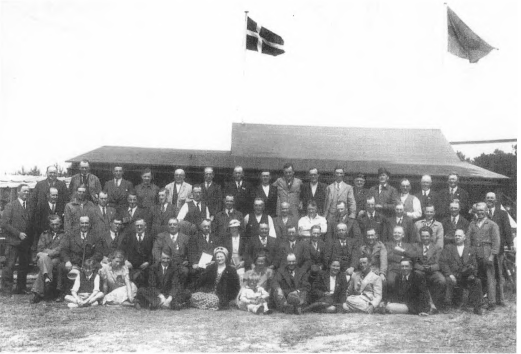
Skytter fra Bornholm og Skåne i 1938 foran Skydehuset (opført ca. 1930, nedlagt i 1968).
