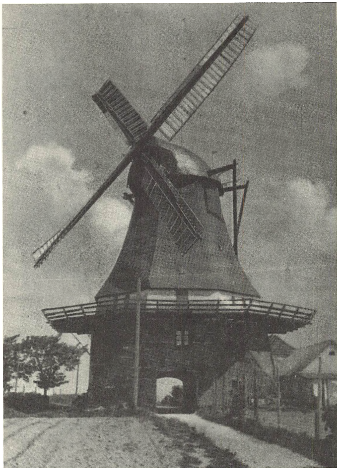
Toftlund Søndermølle kort for nedbrydningen i 1938. - Den tunge møllehat med de store vinger drejedes fra omgangen med røkværket. - Møllen er drejet op mod vind fra sydvest.
