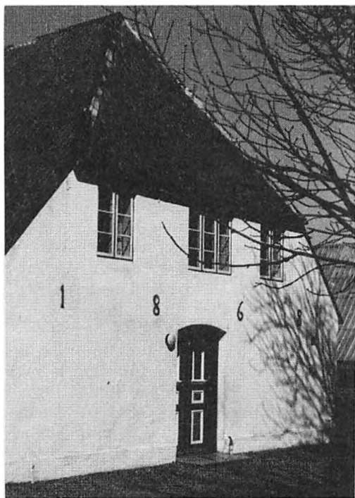
Gavl med indgangsdør på Gårdeslægtens gamle slægtsgård i Rurup.
