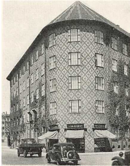
Et Hus paa Aaboulevarden, hvor man ved Hjælp af røde og gule Mursten har lavet en særpræget Facadebeklædning,
