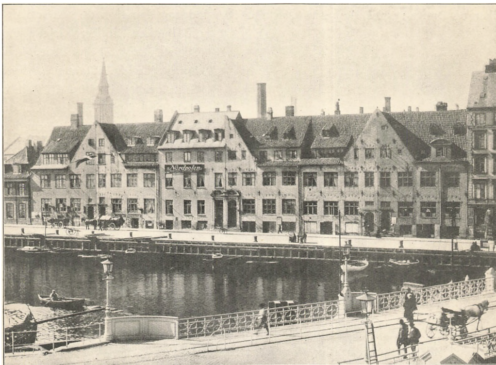
De 6 Søstre kort forinden Nedrivningen.
