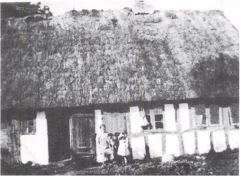
Gammelt skovløberhus (?) ved sogneskellet mellem Egtved og Vester Nebel (nu Egtvedvej 116). Fot. 1937-1938.
