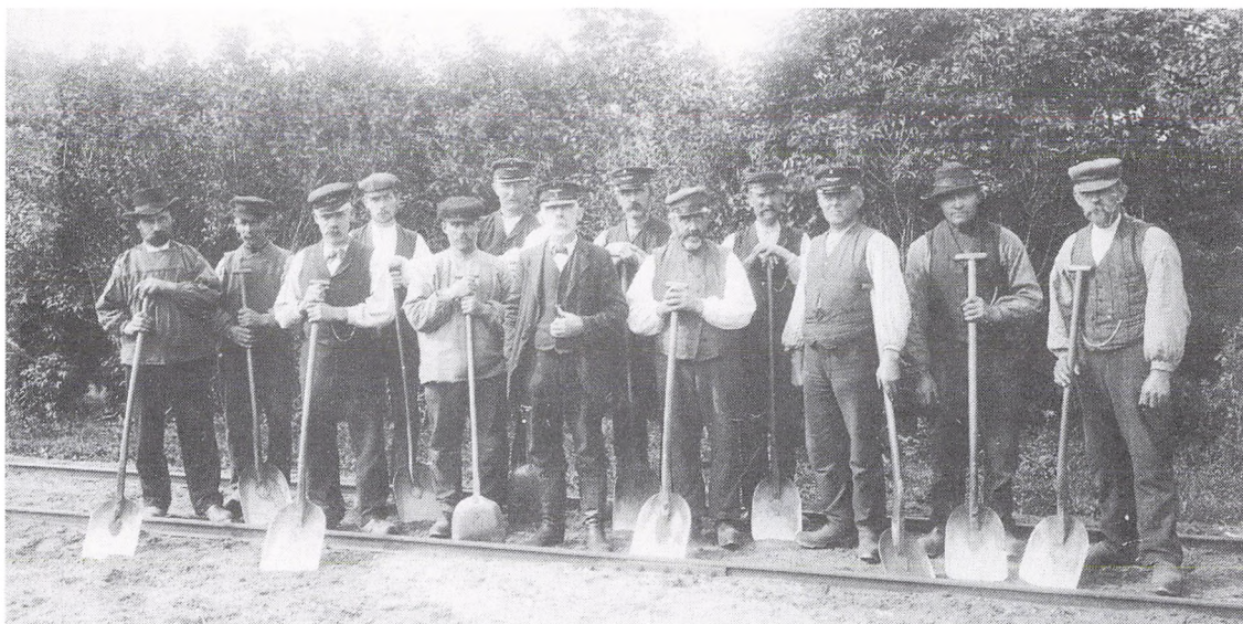
Arbejderne ved Egtvedbanen ca. 1910.
