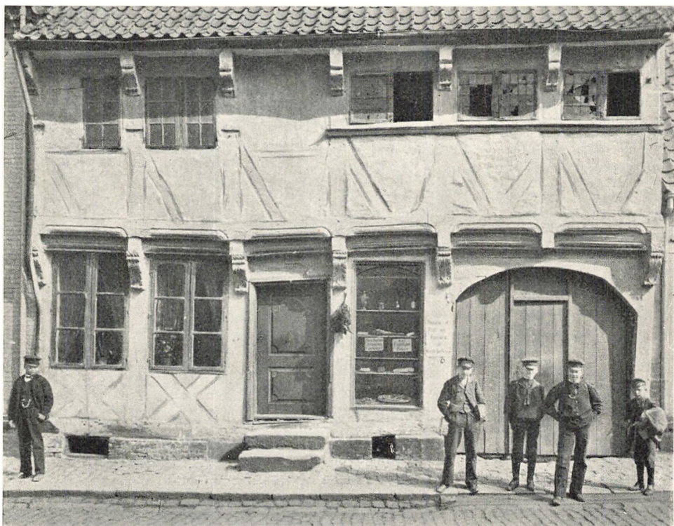
Mejlgade 30 (nedrevet). Den gamle By.
