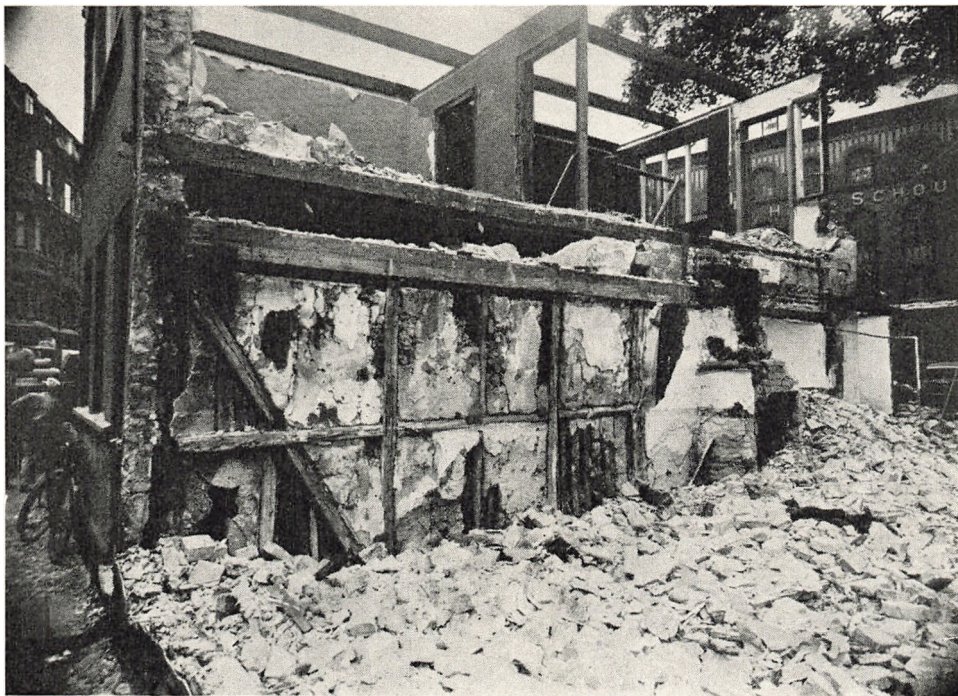
Tangen 17 under Nedrivning Sommeren 1937.
