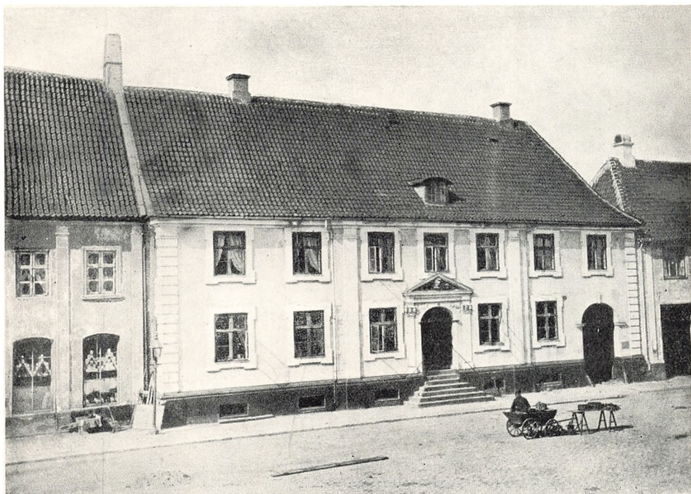
Løveapoteket før Ombygningen 1876—77.
