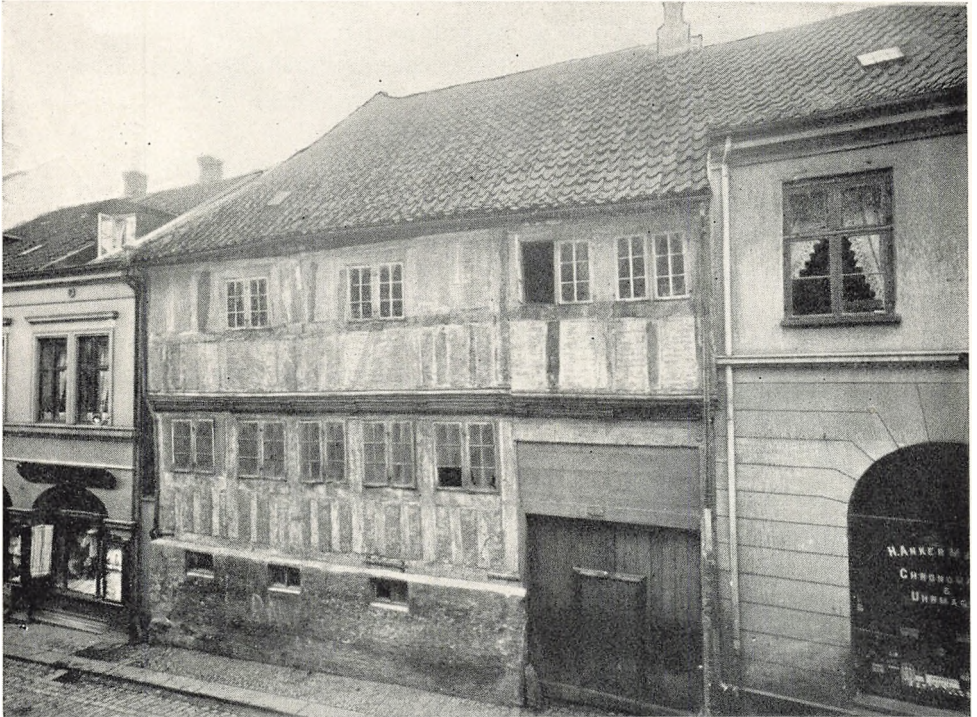
Garrisonssygehuset paa Frederiksgade. Nedrevet 1907.
