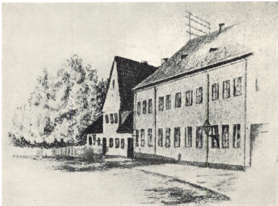
Sygehuset i Dynkarken. Overlægebolig og Have til venstre.
