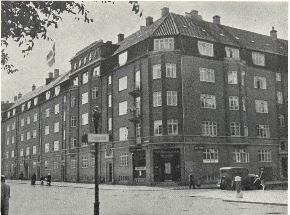
Ingerslevsgaard, opført af Arbejdernes Andels-Boligforening.
