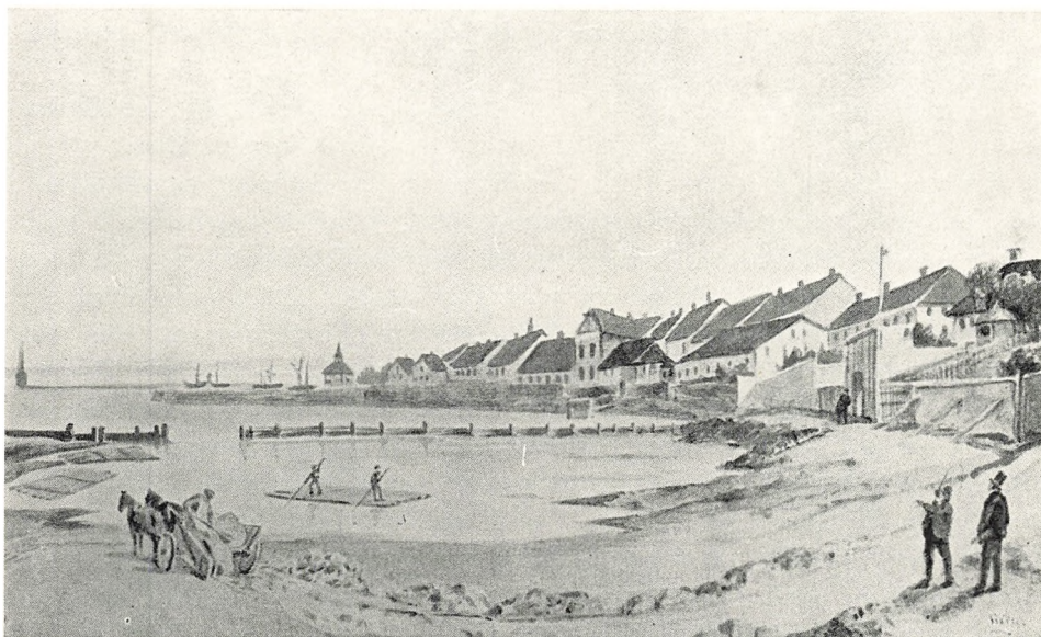
Fra Bygningen af Bassin I i 1840erne.
