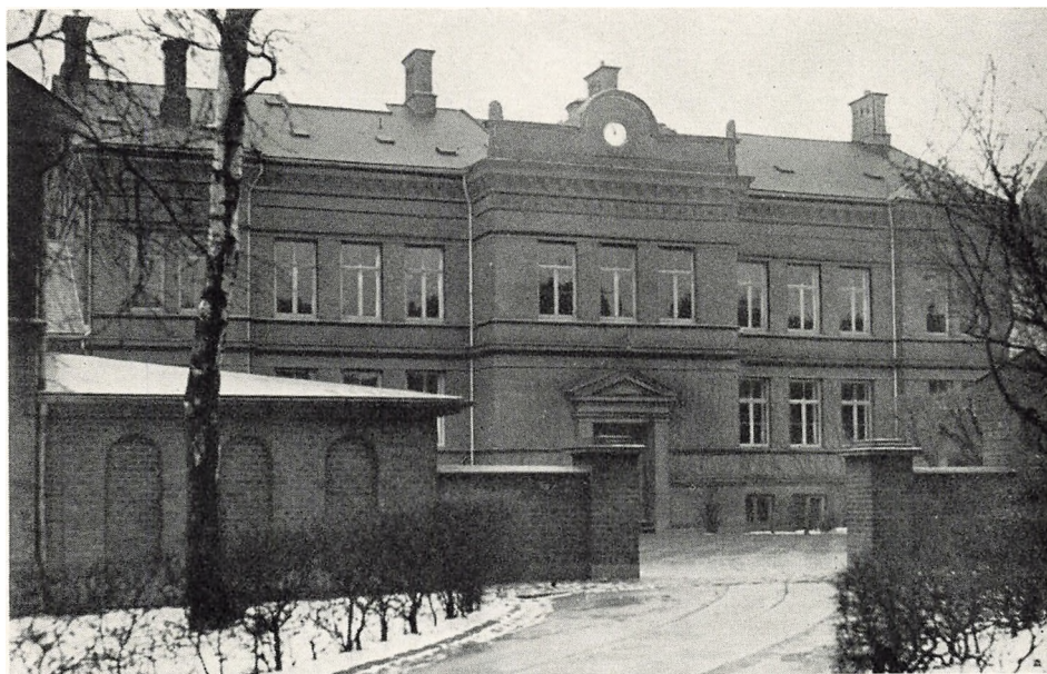
Ældre Skolebygning. Ny Munkegades Skole. Foto Stadsingeniørens Kontor.
