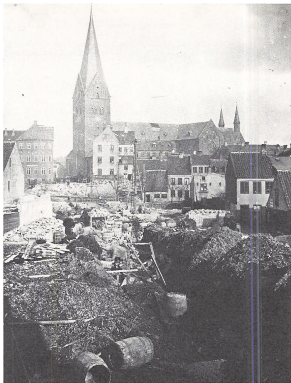
Fotografi af byggepladsen ved begyndelse af arbejderne til Sct. Clemensbro vinteren 1882-83. I baggrunden står et par rambukke og slår pæle ned til bropiller og støttemurene. Her ses desuden stabler med granitblokke til murene. I forgrunden er udgravningen i gang til broens vanger ved Søndergade. (Foto i Lokalthistorisk Samling).
