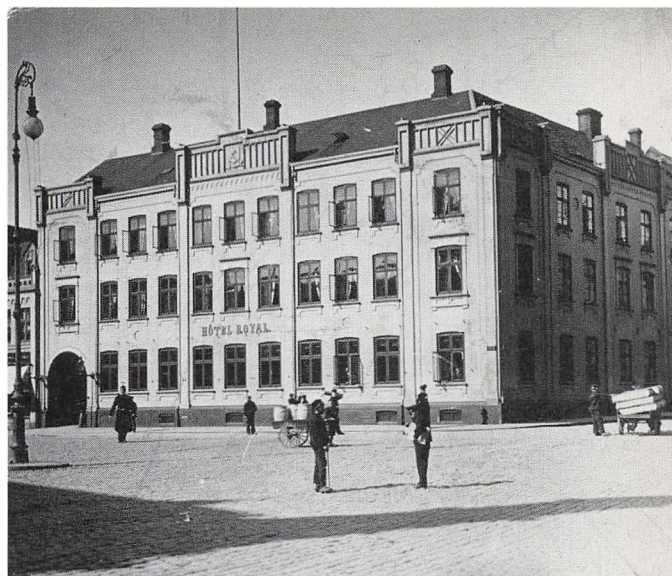
»Royal« omkring århundredskiftet. Bortset fra »borgmurs«-udsmykningen var hotellets ydre stort set uforandret, siden 3. etage var blevet påsat omkring 1850. Få år senere, i 1902-03, blev hotellet gennemgribende ombygget og fik sit nuværende udseende. En 4. etage kom til samt et højt mansardtag med smukke trekantede og halvcirkelformede kviste. Mod Store Torv blev facaden endvidere udsmykket med de pilastre, balkoner og relieffer, der er med til at give bygningen det fornemme og statelige præg. (Foto i Erhvervsarkivet)
