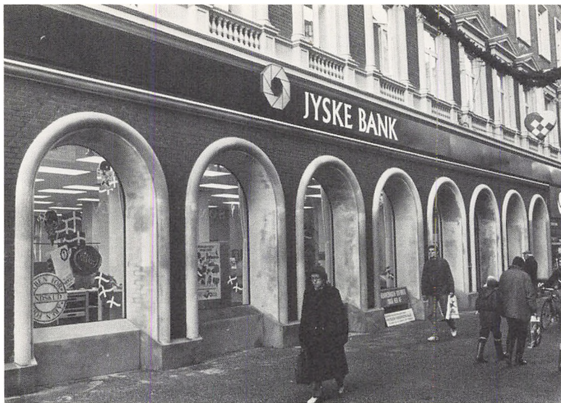
Jyske Banks hovedafdeling i Århus fremtrådte den 25. november med ny facade. Dvs. facaden er faktisk ikke ny, men den som huset havde omkring århundredeskiftet. (Foto: Dan Jakobsen)
