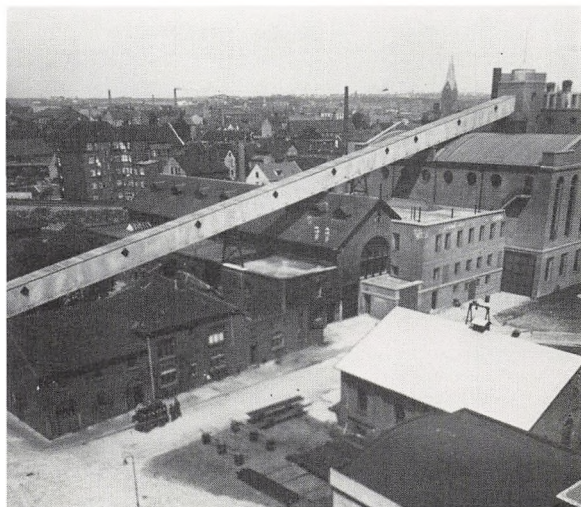
I den 125 meter lange lukkede kultransportør blev kullene ført på et skålformet gummibånd op over det gamle elektricitetsværk til det nye 34 meter høje kedelhus' siloer med plads til 400 tons. Kullene glider ved egen tyngde ned i otte automatiske vægte i siloernes bund og brændes på langsomt roterende kæderiste under de fire store dampkedler.
