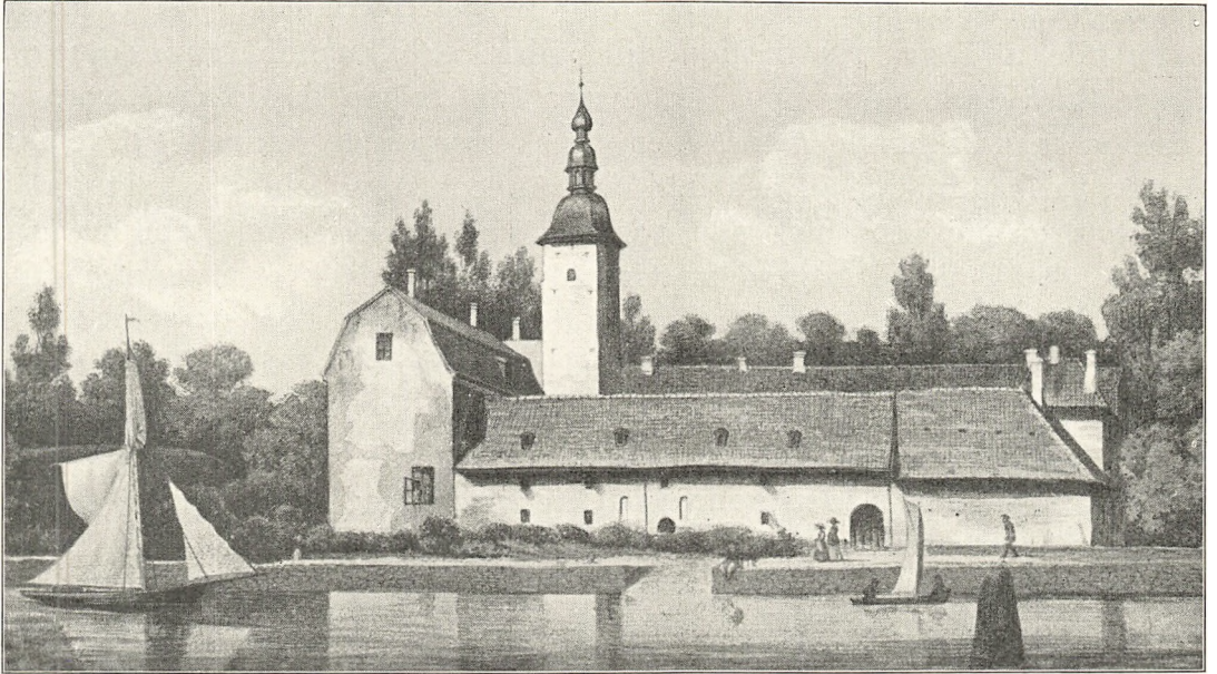
Afb. 91. Halmstads slott från öster. Pennteckning 1858. Det stora tornet och den lilla portöverbyggnaden i norra längan markera slottets huvudaxel i norr—söder. Tornets övre fönster sitta alla på nordsidan. I öster och väster finnas små luckor, medan sydsidan ej har någon öppning i muren. Detta är det enda fortifikatoriska draget i tornets arkitektur.
