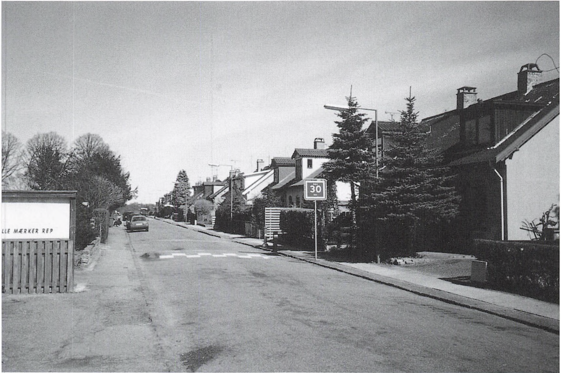
Fig. 7. Østsiden af Brønshøjholms Allé med nogle af den kooperative byggeforening Enighedens 50 dobbelthuse. Her er havebyprincippet slået igennem. Det giver tillige med de forholdsvis brede veje et indtryk af god plads trods husenes lidenhed.
