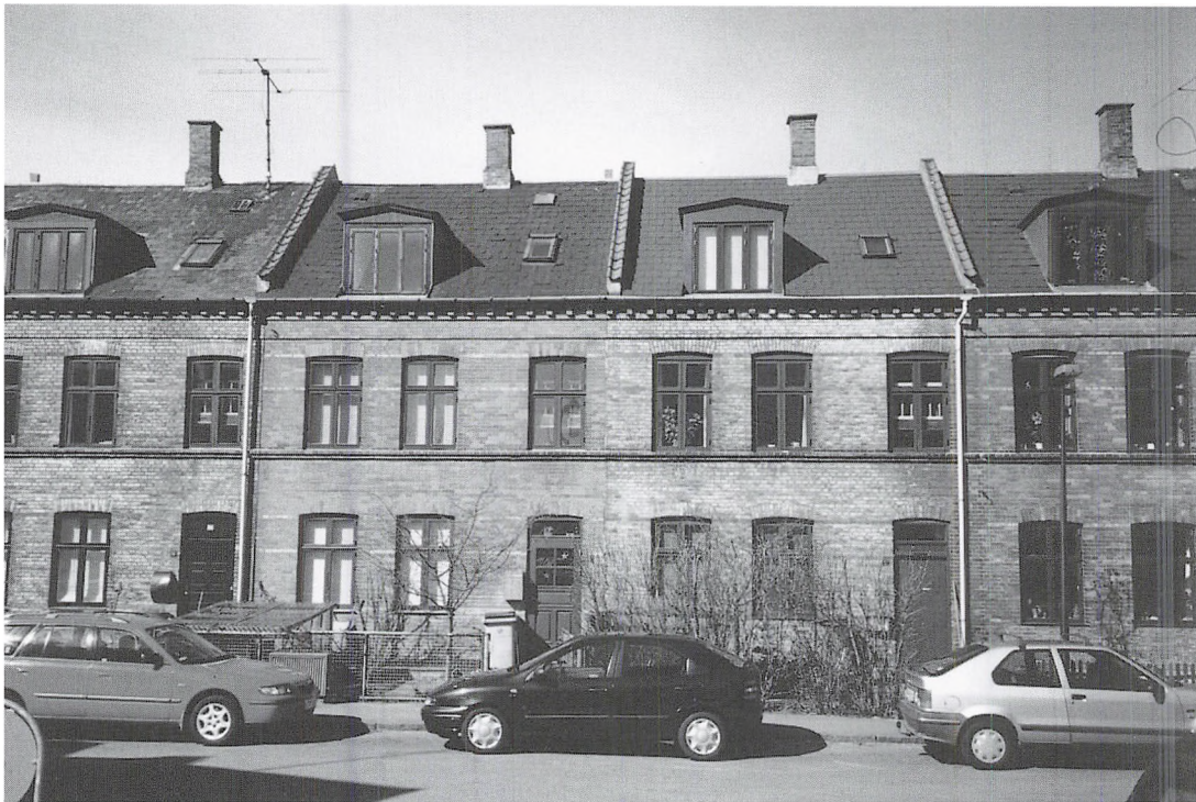
Fig. 6. Toftebakkevej i Valby. Som det ses er husene ens, men skiftevis opført i gule og røde sten med bånd »i den modsatte farve«.
