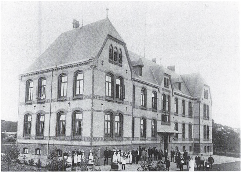
Sygehusets front med hovedindgang set fra sydvest kort efter den blev bygget. (Historiske samlinger, Aabenraa).
