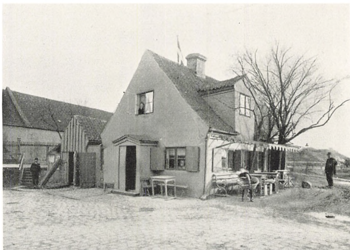
Bomhuset ved Langebro.
