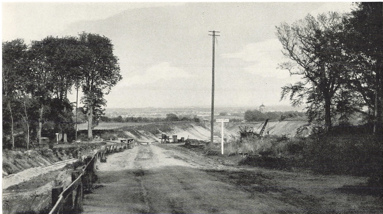
Fra Forarbejdet til Lillebæltbroen.
