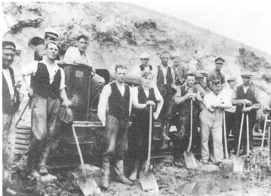
Yding 1940: Den "nye vej" anlægges. Bag ved arbejderne ses det dieseldrevne tipvognstog, der kørte jorden bort. Det nye grusmateriale kom især fra grusgravene ved Birknæs. Lokalarhivet, Gedved.
