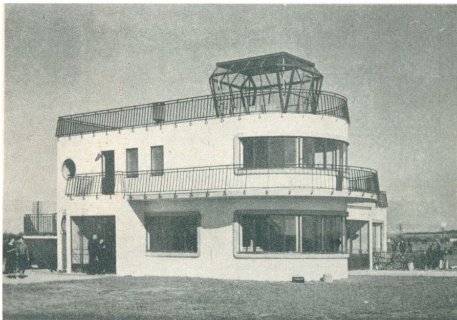
Administrationsbygningen i Aalborg Lufthavn.
