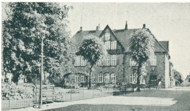
Lille Torv med Posthuset, opført af Sandsten.
