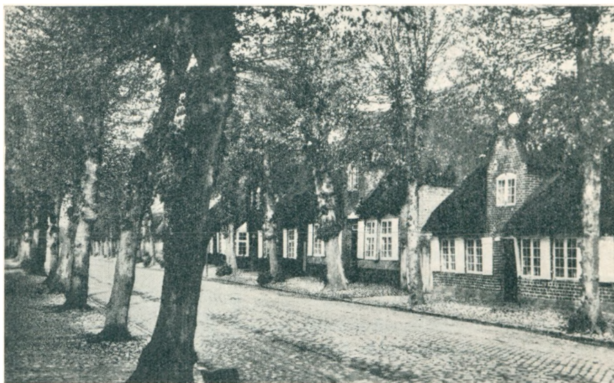
Slotsgade i Møgeltønder.
