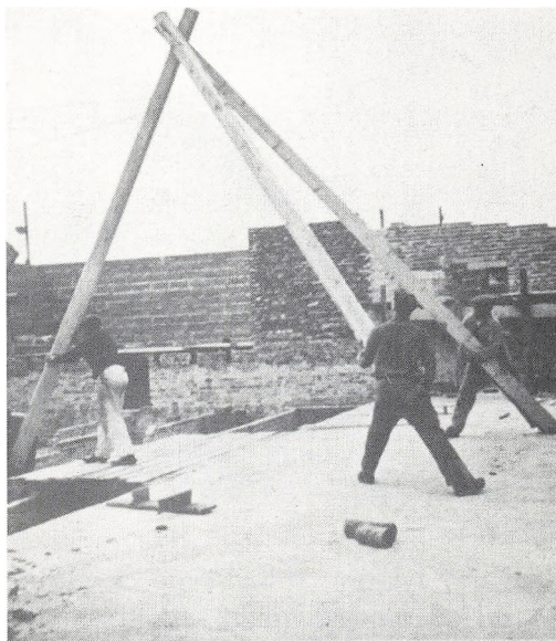
Et treben bliver rejst for at kunne lægge jerndrageren mellem loggia og sal på plads.
