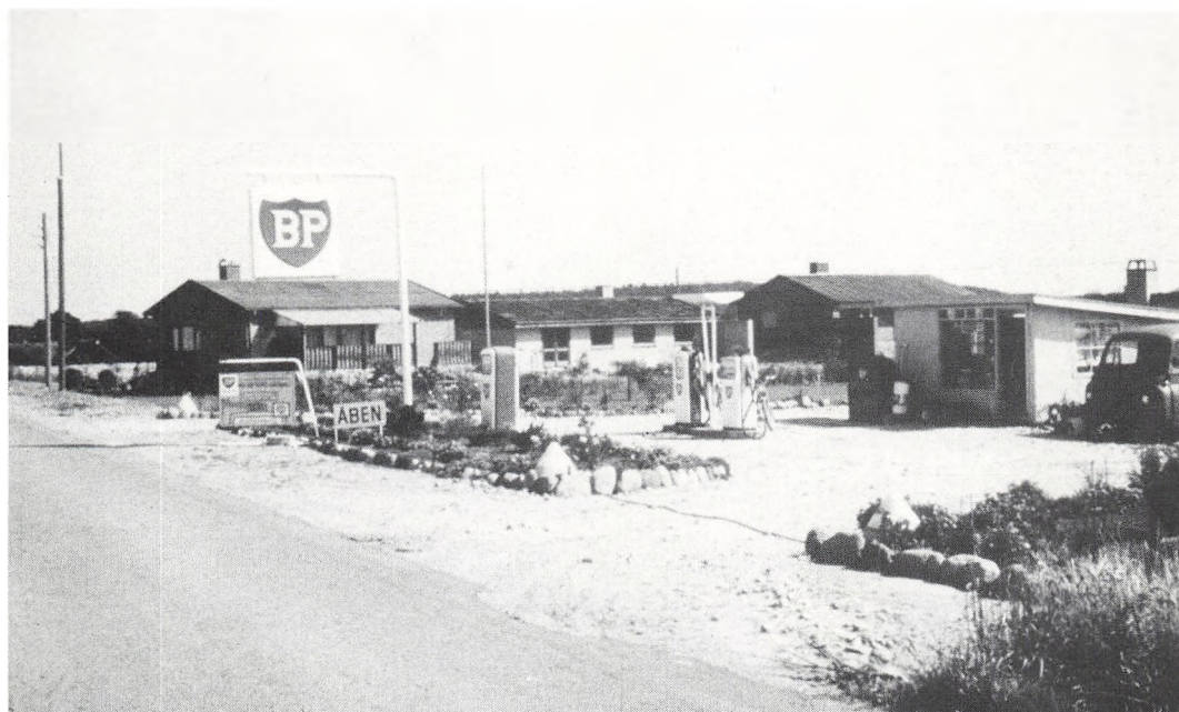
På Klokkekildevej 10 (på hjørnet ved Hesselvej) var der tankstation fra ca. 1964 til 1974.
