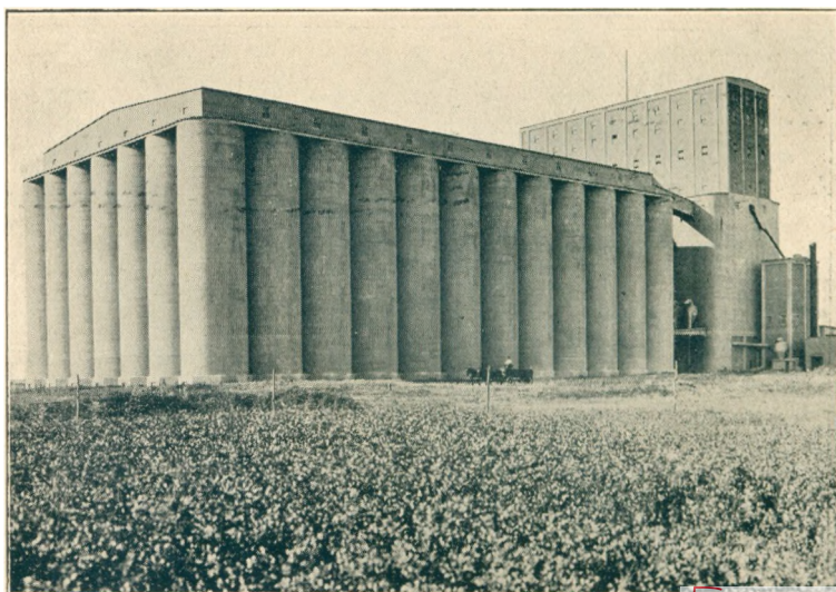
En Kornelevator i Saskatoon. Den er opført af Jernbeton og rummer 1 Million Tønder Korn.
