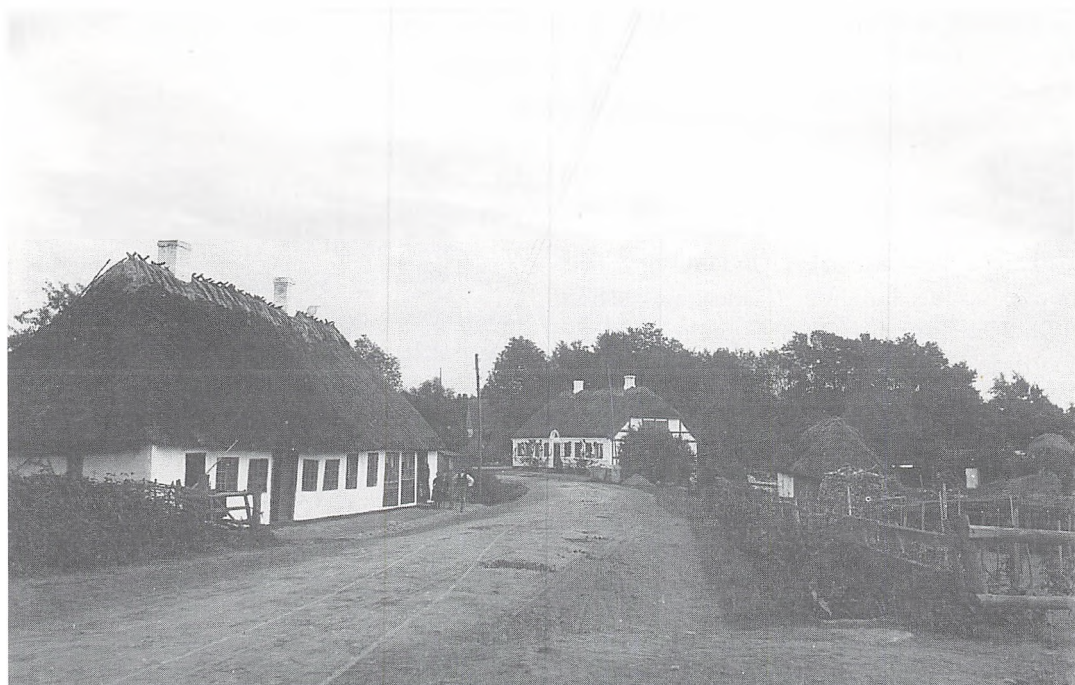
Fig. 2. Sundbrovej nr. 51. (huset til venstre) (Foto: Emil Hansen, Svendborg).
