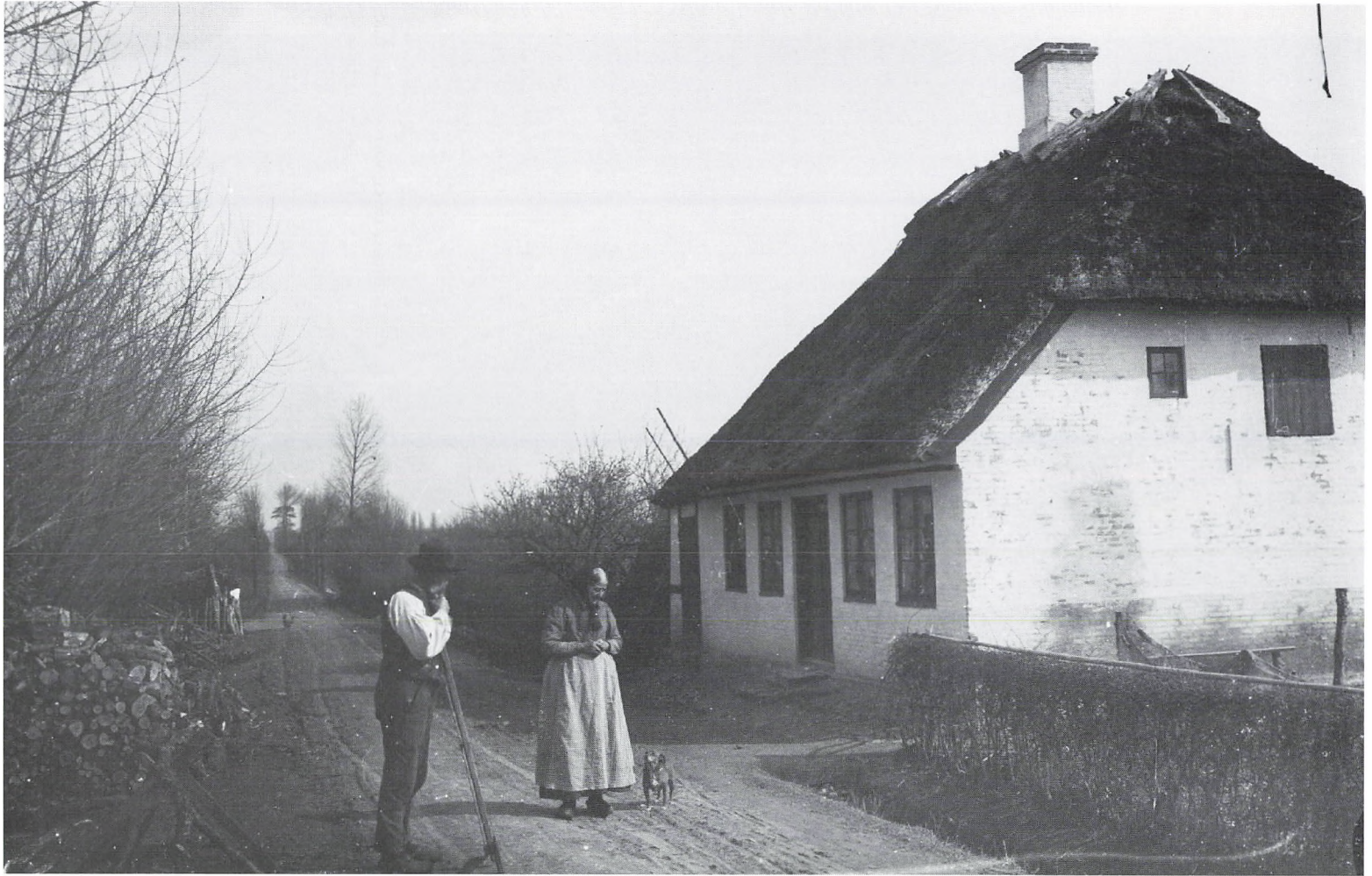
Foto fra Søren Lolks samling med titlen: "Jørgen Mose og kone," (foto før 1913), (nuv. Vornæsvej 51). Det var en kopi fra samme negativ, som Kevin Kirby bragte med fra U. S. A., da han søgte sine aner på Tåsinge d. 3. og 7. september 1998.
