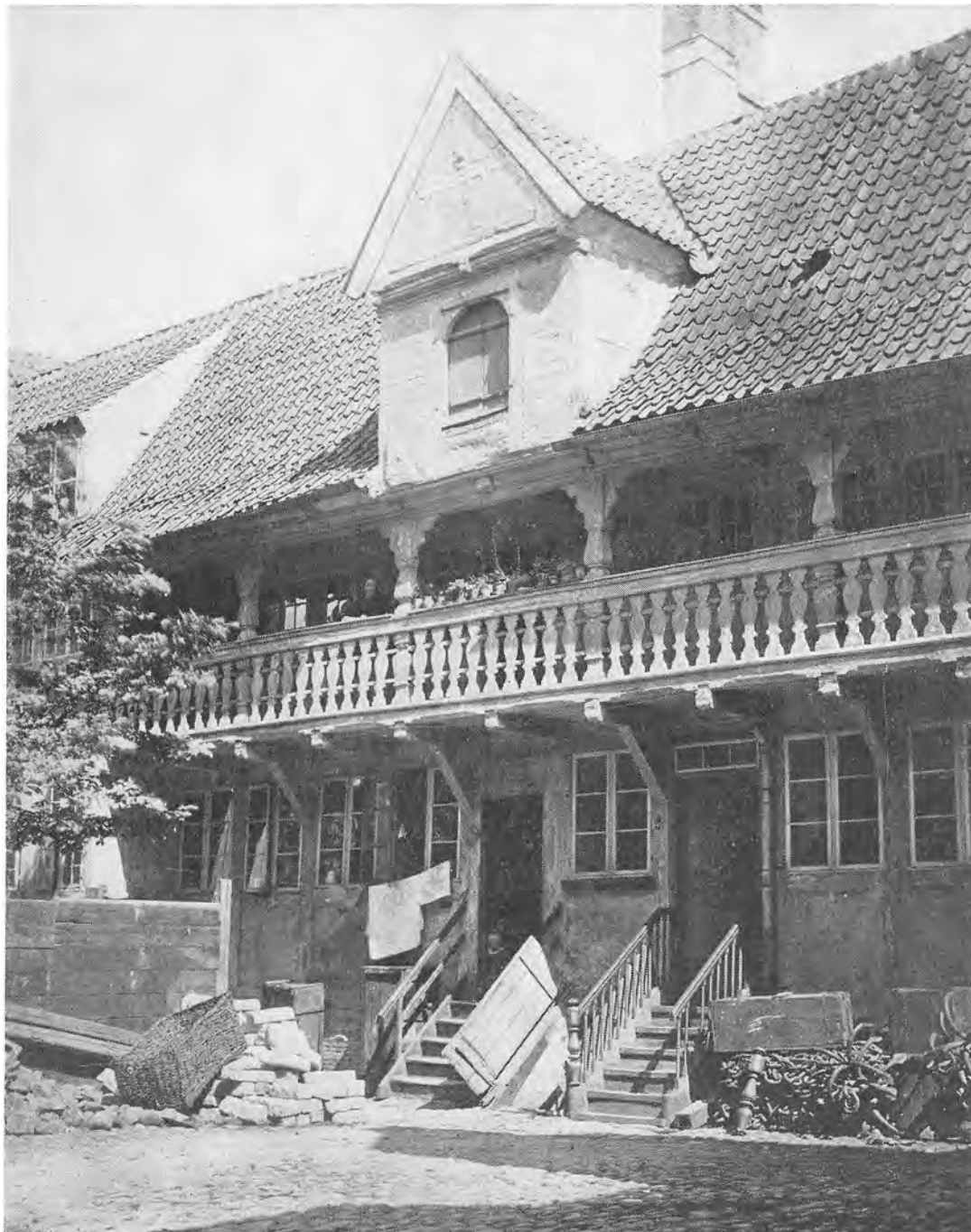
52. Den Grønbeckske Gård i Slotsholmsgade set fra gårdsiden. E. V. Harboe fot. 1867. 24,3×19,3 cm. Del af den østlige sidefløj med svalegang fra 1600tallet. Nedbrudt ved anlægget af Christiansgade, hvor nu Ministerialbygningen, Slotsholmsgade 12, ligger.
