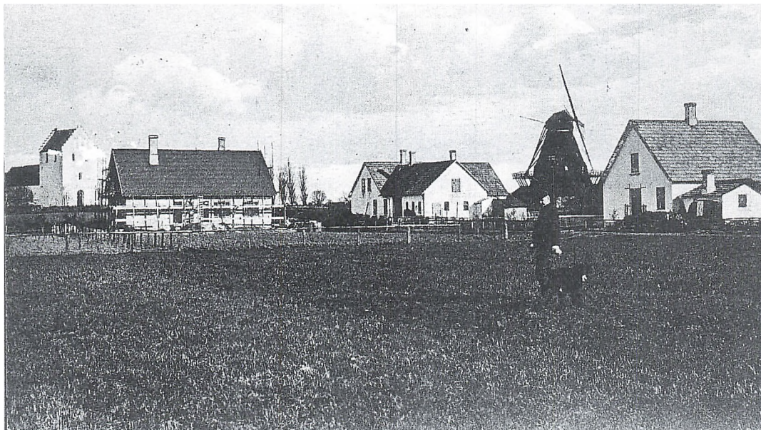
Landet bageri under opførelse ca. 1909.
