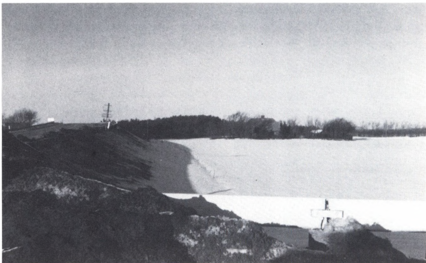
Udsigt ved viadukten mod Voldbjerg skole.
