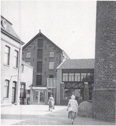
Hovedindgangen til Nederlands Textielmuseum i Tilburg, som i 1986 blev indrettet i Mommers & Co gamle fabriksbygninger.
