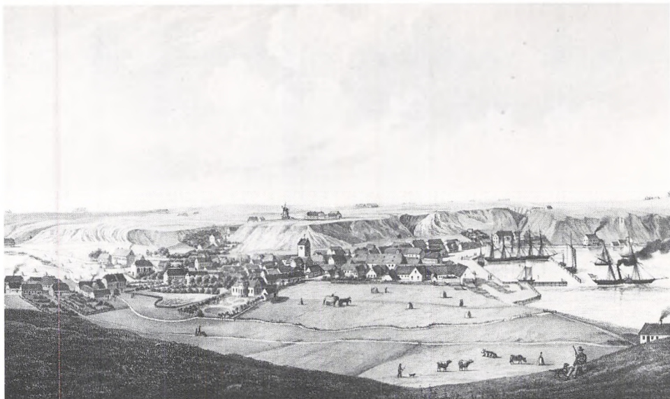
Lemvig med sine mange nybyggede huse i en tæt klynge omkring kirken og Torvet. Også havnen er ny, anlagt af kommunen i 1855-57. Lithografi efter J. Gjørup, Lemvig, ca. 1860.
