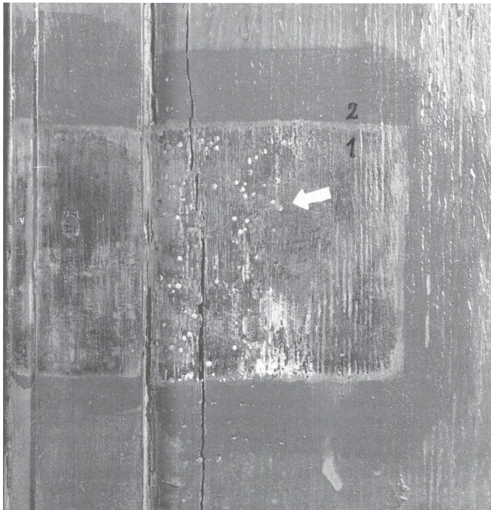
Afdækning af oprindelig bemaling (1) på højre gavl. Den oprindelige bemaling består kun af et farvelæg. Bemaling nr. 2 er den nuværende, overliggende. Pilen viser de med kitmasse udfyldte borebillehuller og derunder farveafskalninger. Foto: Rita Fredsgaard Nielsen.
