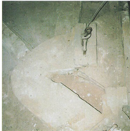
Røgkanal og koldluftskanal set ovenfra.
