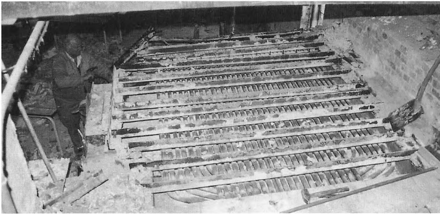
Marengsovnens varmerør afdækket.
