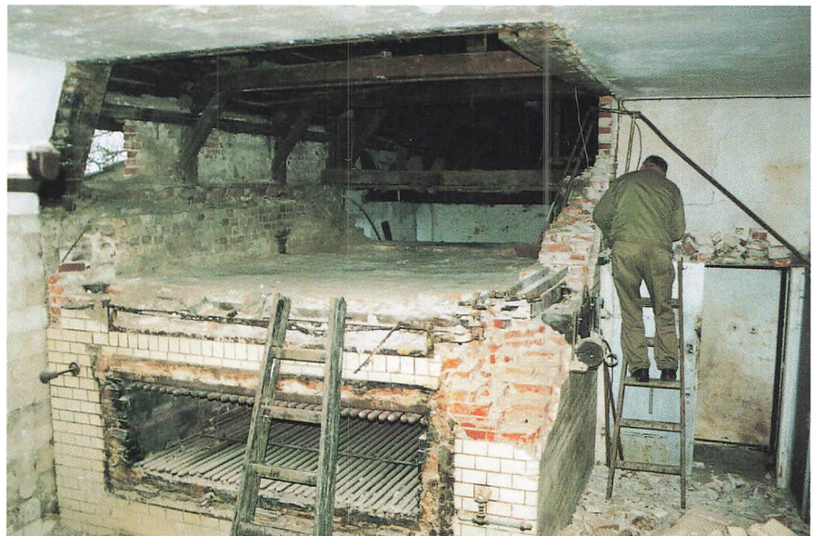
Røgkanal og koldluftskanaler fjernet.
