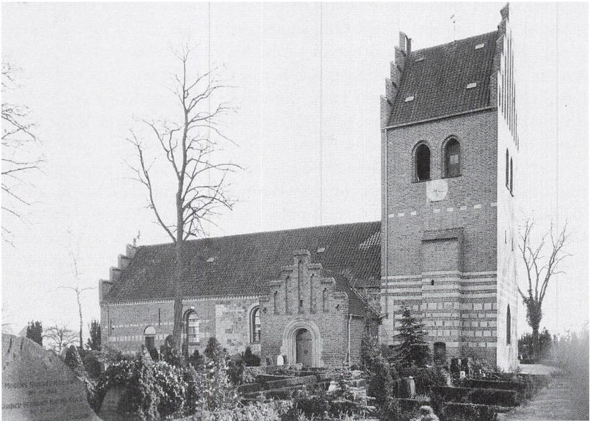
Gladsaxe Kirke, foto 1980. Til venstre for våbenhuset ses den oprindelige del, bygget af mark- og kridtsten i 1100-tallet.
