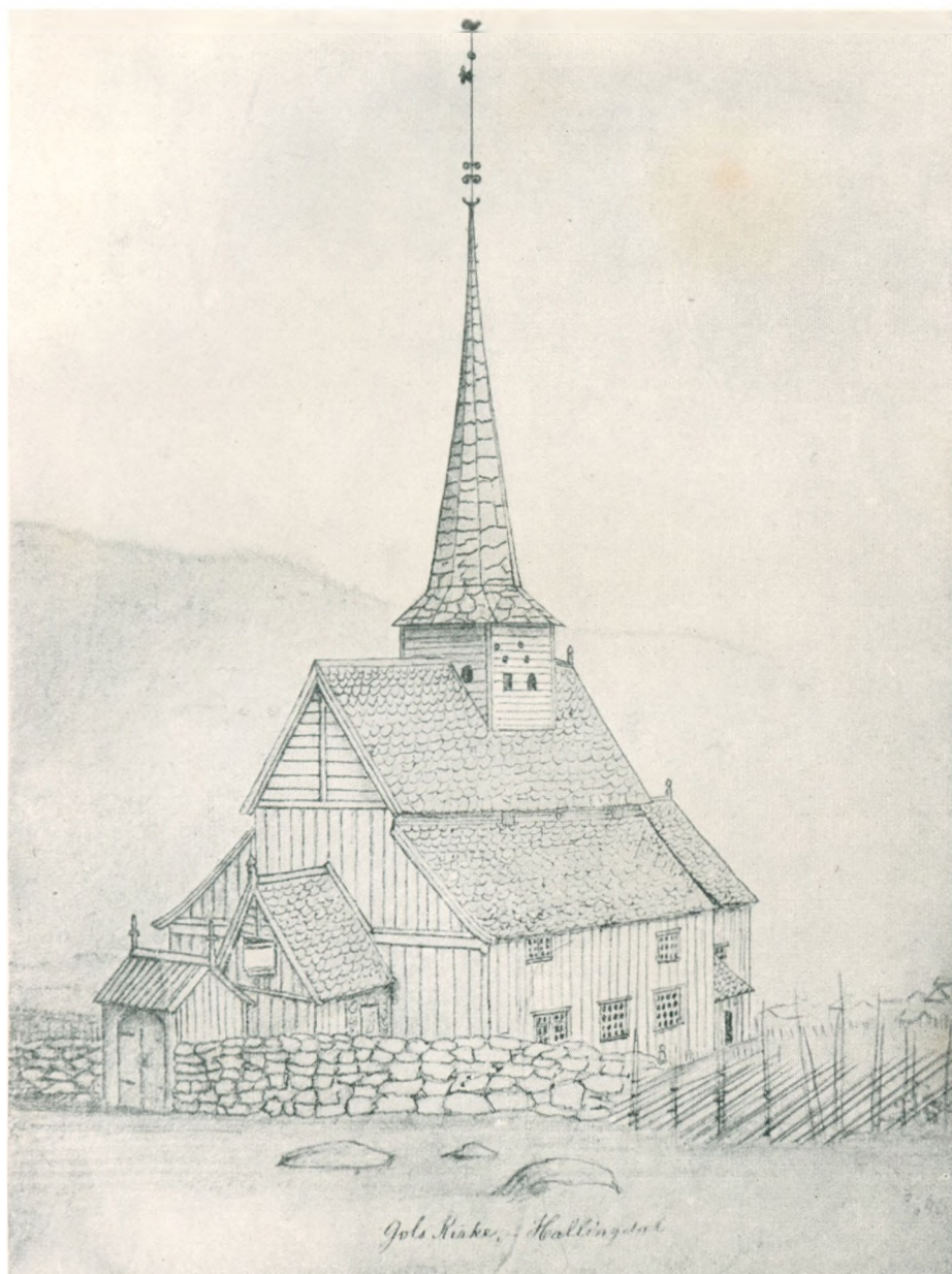
Gol stavkirke efter en tegning i 1842, før „restaureringen“.
