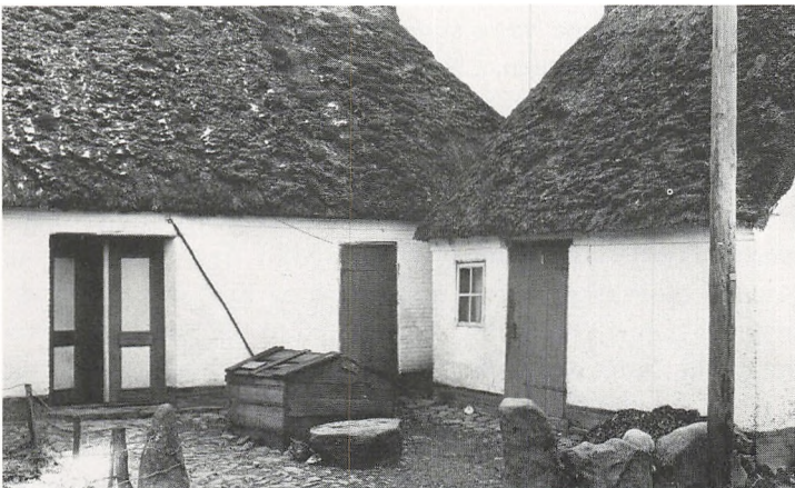
Fig. 15: „Tærskelsten“ til bankning af vasketøj ved siden af brøndhus ved et hus i Løjt Kirkeby. Fot. 1925.
