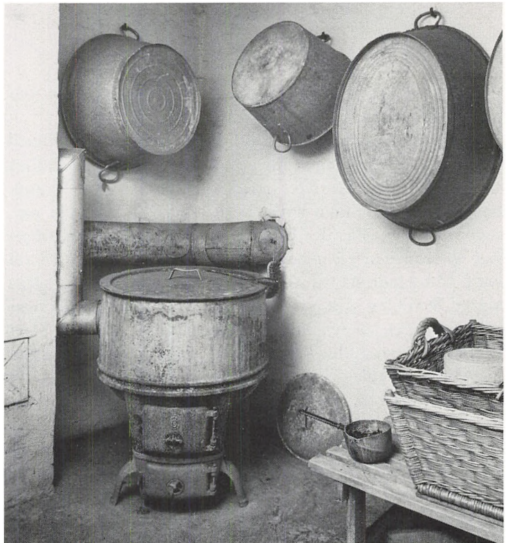
Fig. 9: Vaskekælder fra rækkehus i Ordrup. Vaskekedel til kul-fyring. Tilsvarende til gasfyring var almindelige før de elektriske vaskemaskiner kom i brug. Fot. 1951.
