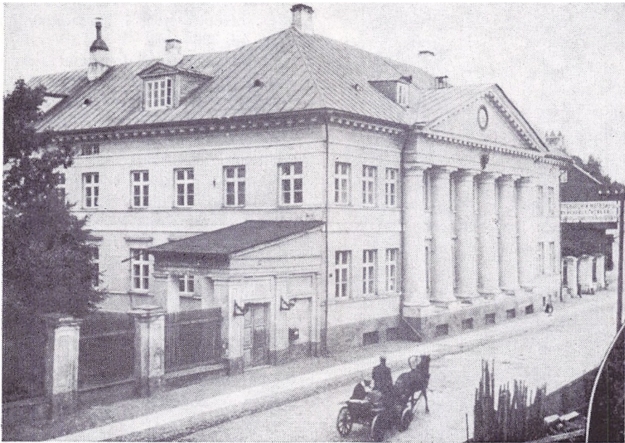
Fig. 14. Dorpat Veterinærskolens hovedbygning ca. 1898.
