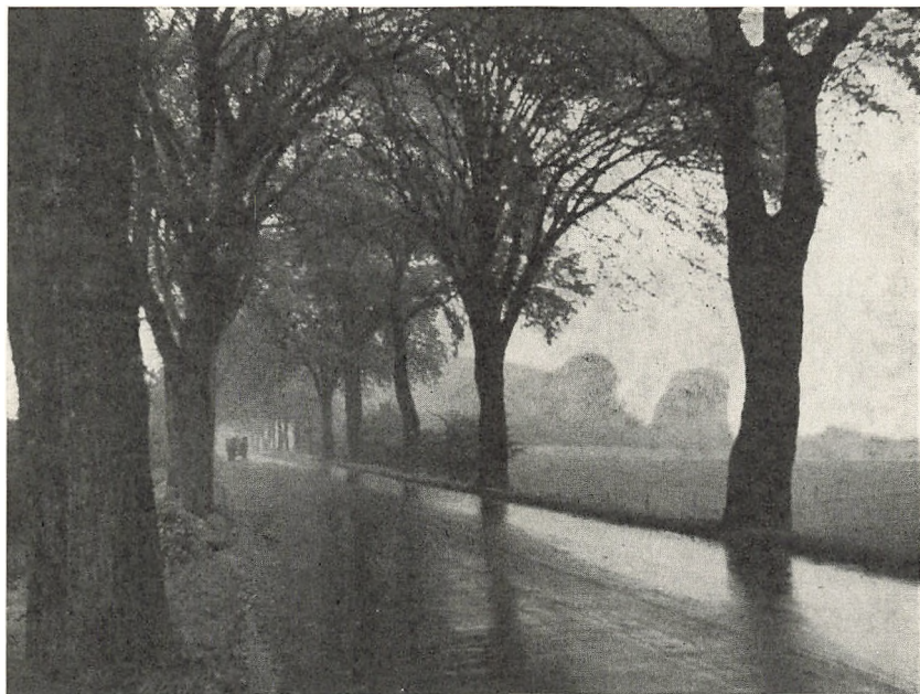
Fra Vothmanns have leveredes også træer til de store chaussées. Dybbøl landevej, fot. ca. 1930.
