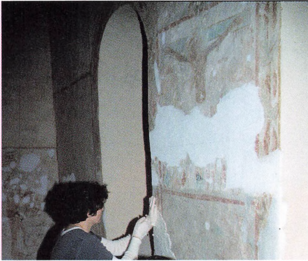
Fig. 2: Afsaltning af scener på korets østvæg: Et kompres af papirpulp lægges på maleriernes overflade. Foto: Isabelle Brajer.
