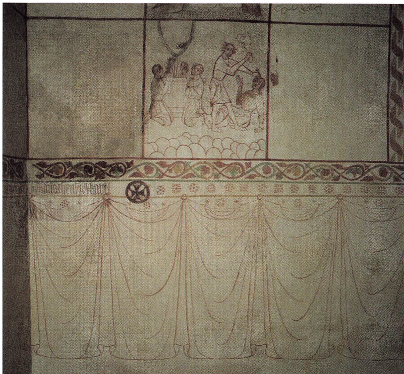
Fig.3: Korets nordvæg: Draperiet og borterne er rekonstruerede på ny puds med undtagelse af originalfragmentet længst til venstre. Forneden i "Kain og Abel"-scenen er et større område på ny puds rekonstrueret med røde konturstreger. Foto: Isabelle Brajer.
