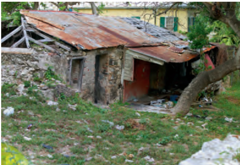
Figur 2. En plantagearbejderbolig i baghaven til ejendommen Dronningens Gade 59, Christiansted på St. Croix (foto: Finn Brasen).
