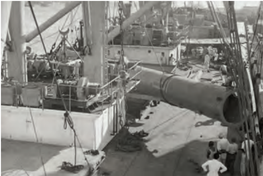
Figur 8. Arbejde på dækket uden sikkerhedsudstyr efter datidens norm. Foto: Henning Jørgensen.
