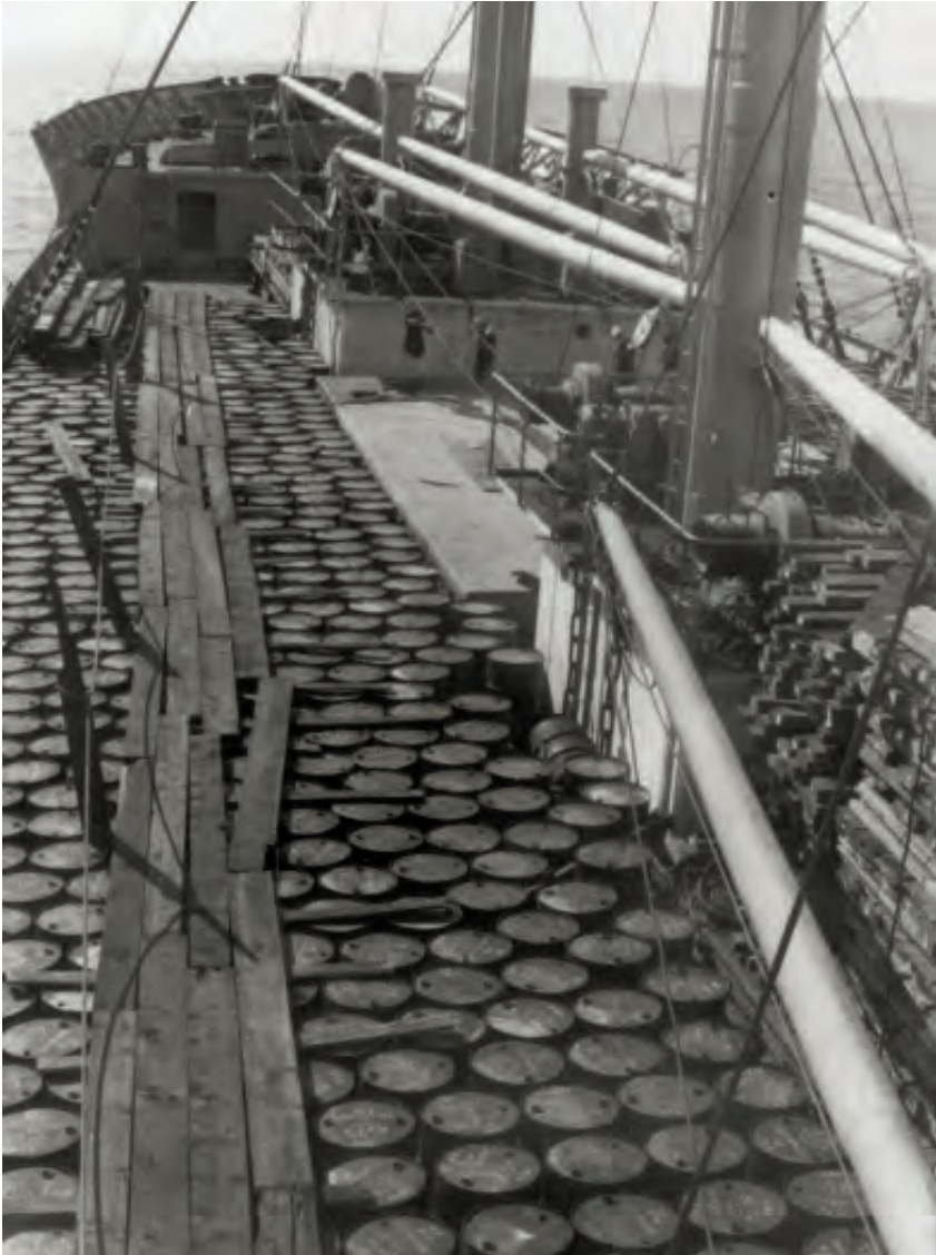
Figur 9. Interimistisk gangbro over dækslast af olietønder til bakken (forskibet) på M/S Malacca i 1950. Indtil først i 1970'erne havde de vagthavende matroser ettimes udkig på bakken i døgnets mørke timer. Der må ikke være lys på skibet foran broen, da dette vil forstyrre navigatørernes nattesyn. Kun i ekstremt dårligt vejr blev udkiggen trukket op på broen. I høj sø var det derfor farligt at færdes på dækket specielt om natten. Foto: Henning Jørgensen.
