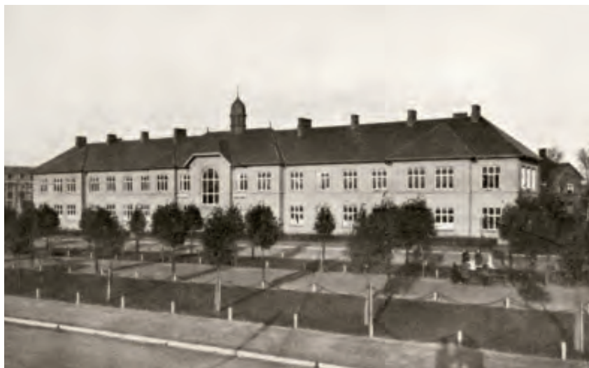
Figur 4. Den nyopførte kirurgiske bygning beliggende ud til Ingerslevs Boulevard (Amtssygehusets årsberetning for 1907).
