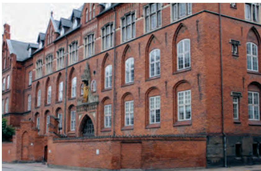
Figur 1a. Sct. Josephs Hospital i Griffenfeldtsgade, København. Hospitalet blev grundlagt i 1873 af de katolske Sct. Joseph Søstre og siden udvidet i flere etaper med den sidste udvidelse i 1904. Det nåede dermed en kapacitet på 400 sengepladser, hvorved det blev et af Københavns største hospitaler. (Foto: Jørgen Vedelskov Serup, 2020)
