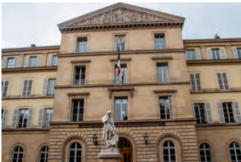
I 1843 flyttede Blindeinstituttet i Paris til denne bygning på Boulevard des Invalides, som ligger der endnu. (Forfatterens foto)
